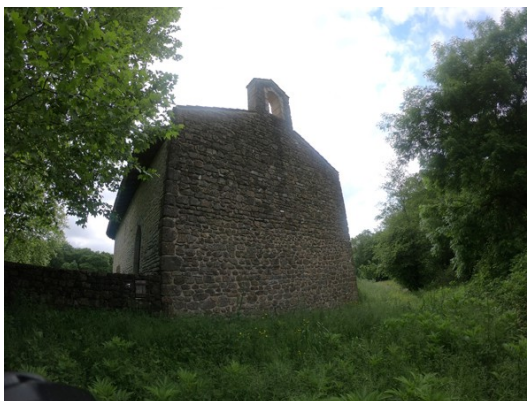
Mur construit avec les pierres récupérées.
